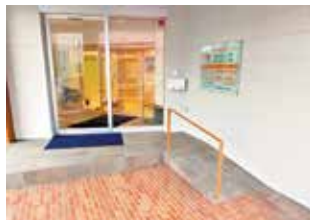
正面玄関 バリアフリーになっています。 車椅子でもそのまま入れます。
